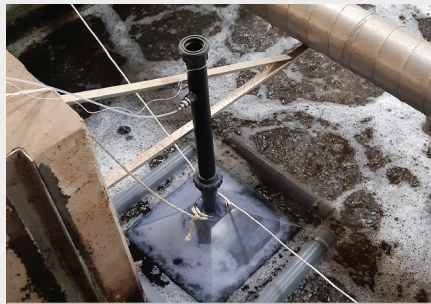
Mesures sur site
